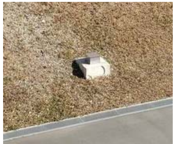
図5 建物周辺地盤の地震計の設置状況
