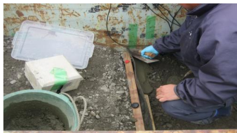
Fig.8 モルタル塗布とベルトの設置の様子
